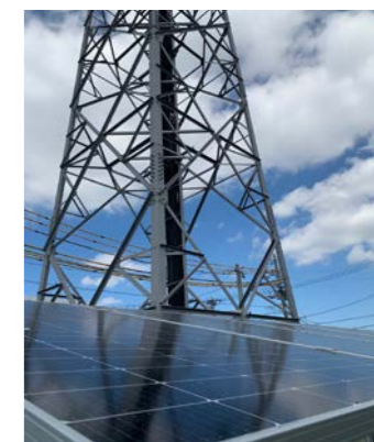
サステナブル基地局
